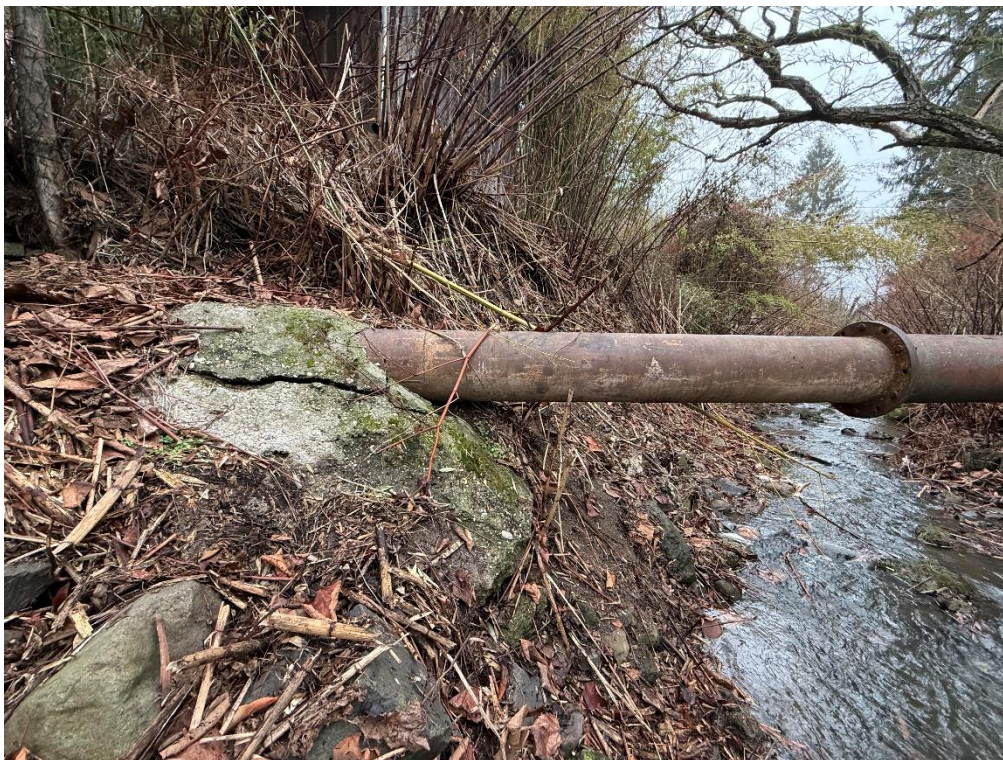
1. kép: Malom-völgyi-patak, áthidaló szennyvízvezeték, összetört alátámasztó betontömb
